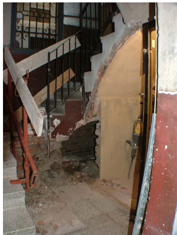
2.-Vista de la demolició parcial de l'escala i de la paret de l'habitació d'aigües
