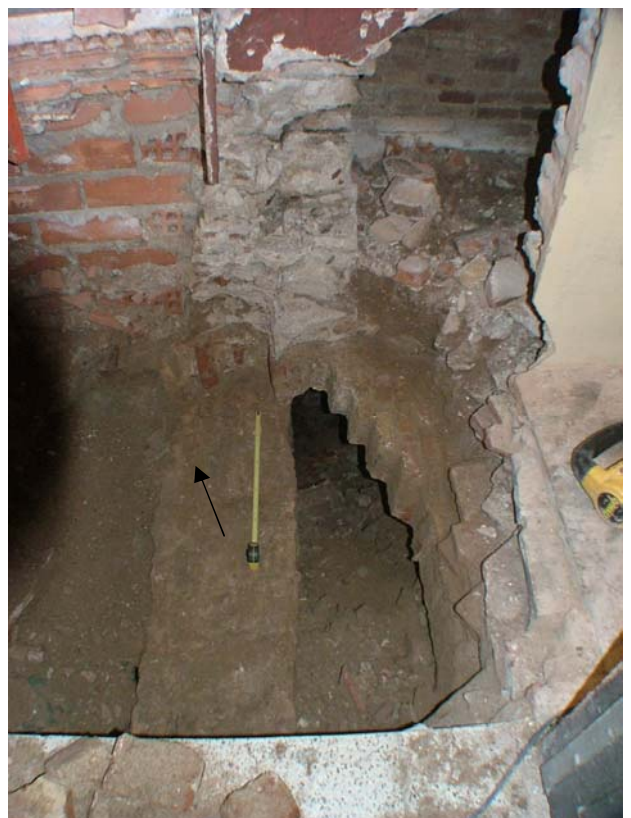
6.- Dipòsit UE 102, un cop desmuntada la coberta 21
