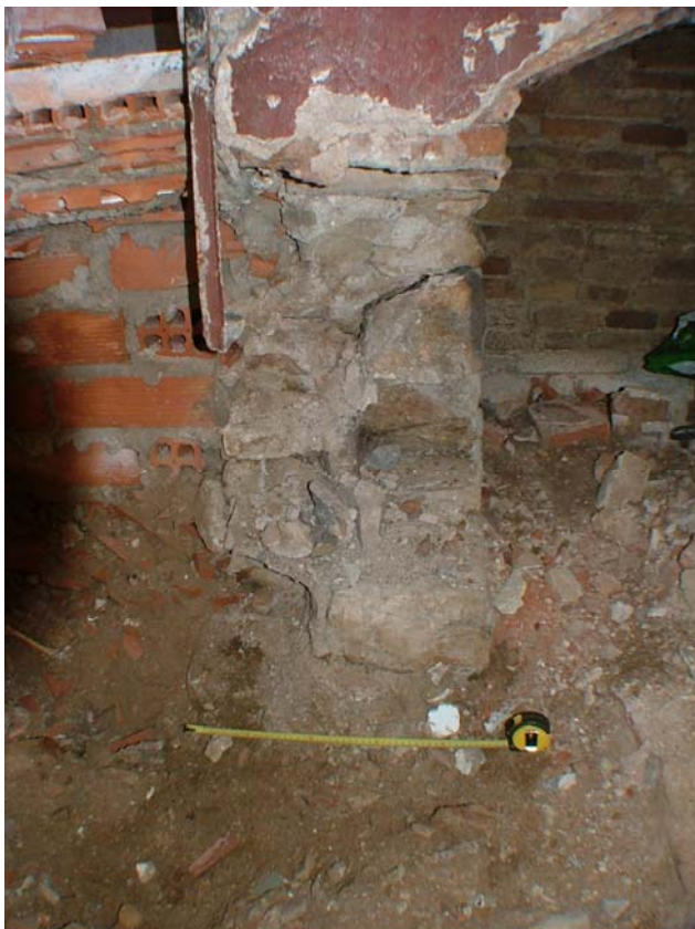
4.-Vista del suport de l'escala (UE 104)
