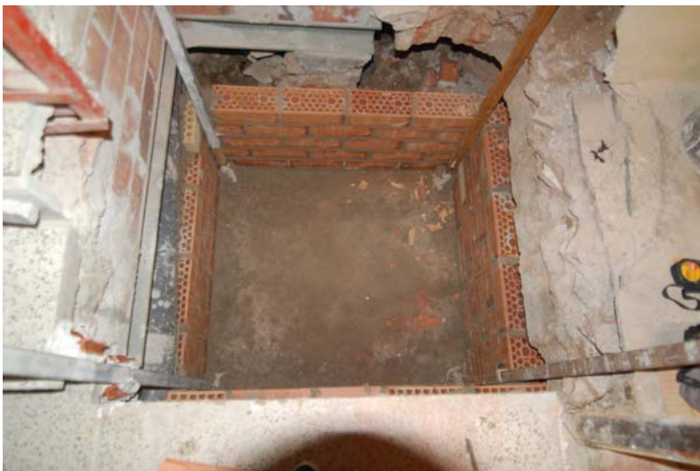
8.-Construcció de la caixa de l'ascensor un cop finalitzada la demolició del dipòsit UE 102
